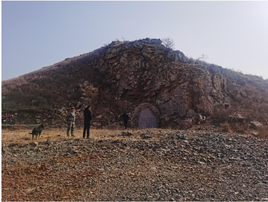
斜井及废石场中斜井（回填、封堵后）切坡
