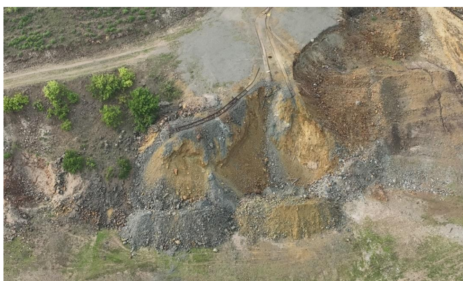
东副井废石场
