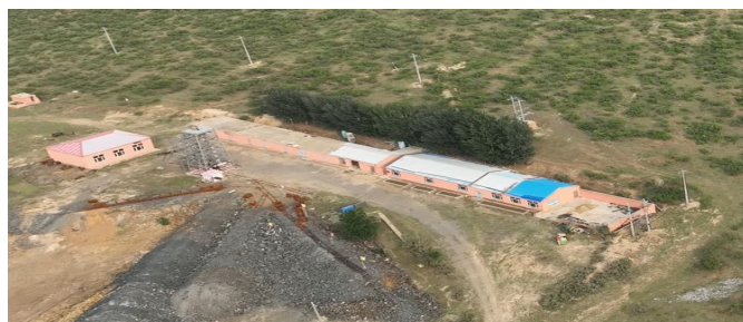
西副井工业场地
