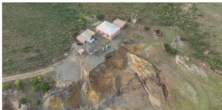
东副井工业场地全貌
