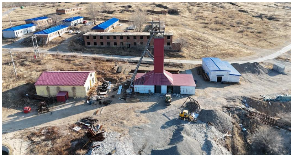
照片 3.1-2 副井工业场地
