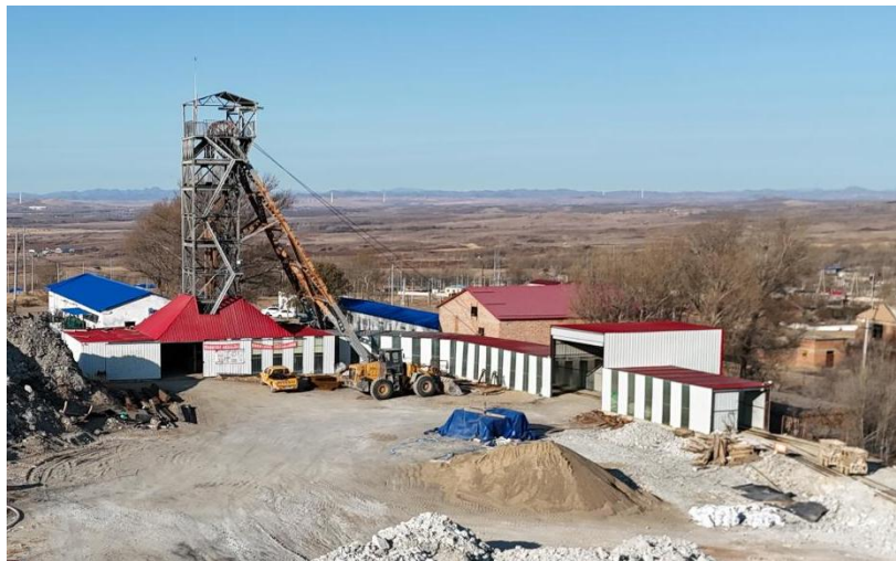
照片 3.1-1 主井工业场地
