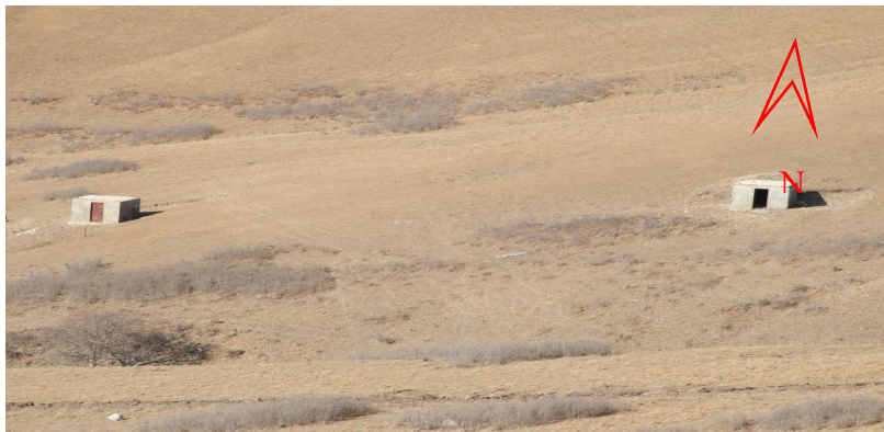
照炸药库与雷管库照片
