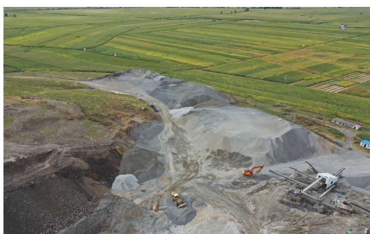
矿石堆放场远景照片
