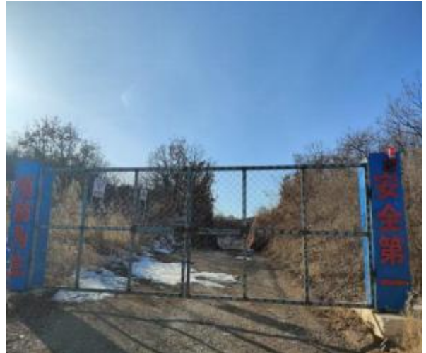
1-4 露天采场设置保护围栏、警示牌
