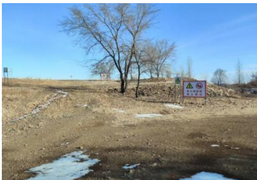
1-5 排土场整平、设置警示牌
