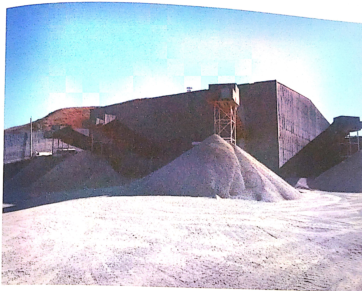
附件照片9 矿石加工二车间
